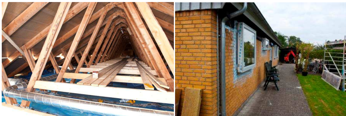
Figur 26. Dampspærre på loft (tv) og fastgørelse og tætning mod ydervæggens øvre del samt lufttæt forbindelse med de nye vinduer og ydervæggen (th). Billeder: Projektlavenergi.dk
