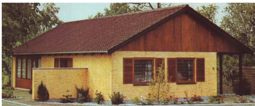
Figur 30. Parcelhus med synlig tagrem (øverst) og nederst et hus med tegloverligger.
