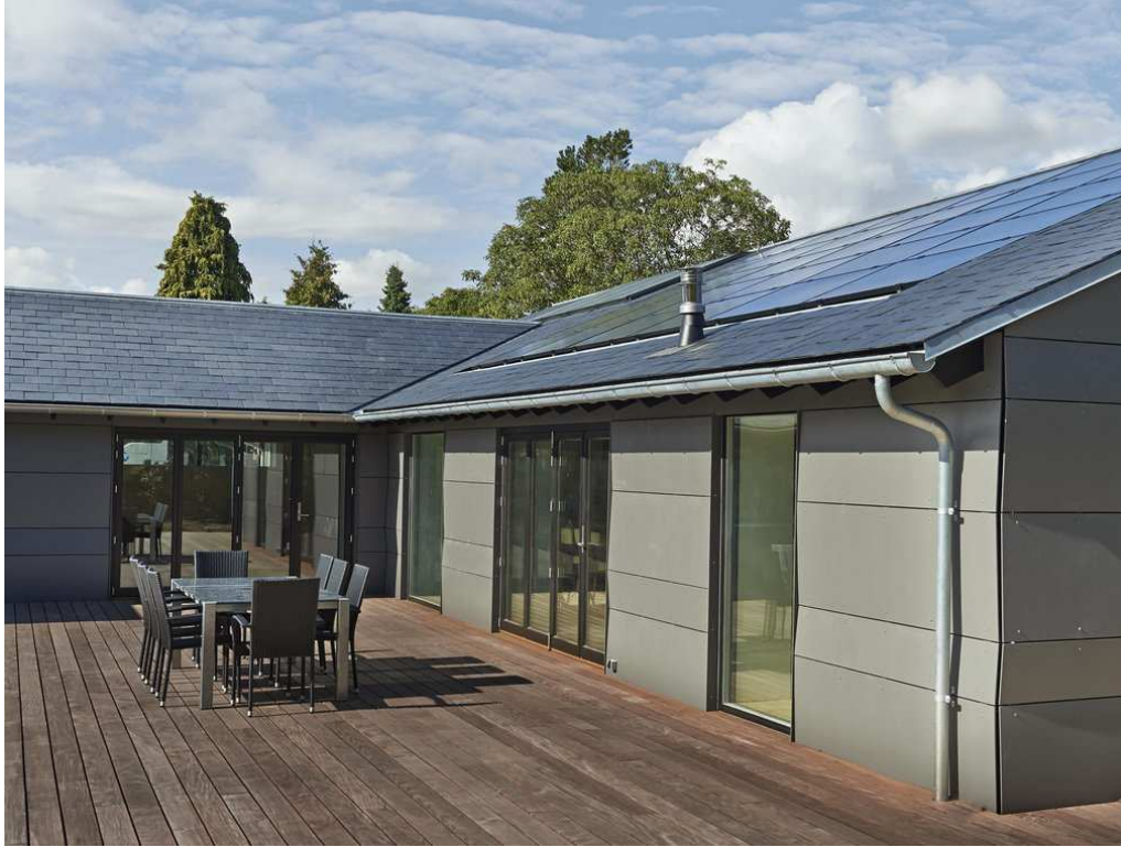
Figur 5 - Eksempel på brug af fibercement på et parcelhus i forbindelse med en renovering.
