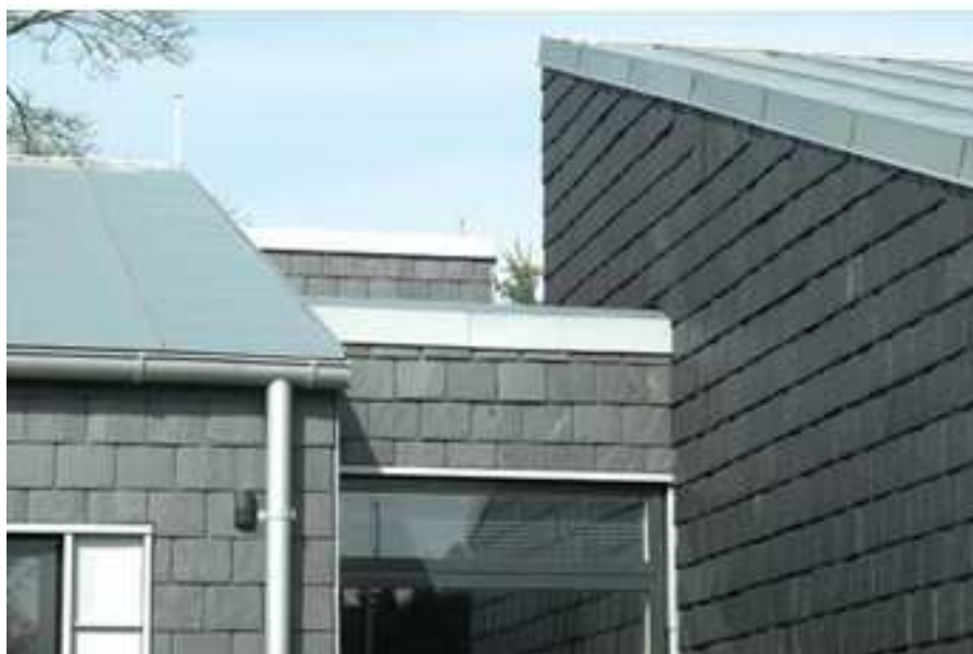
Figur 6 – Eksempel på brug af naturskifer som facadebeklædning.
