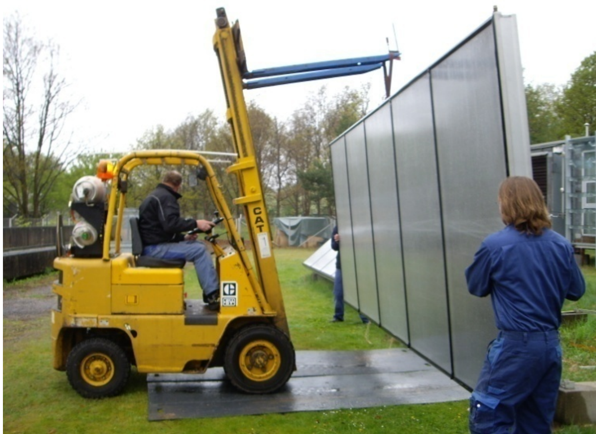
Figur 19. Nedtagning af solfangeren fra Marstal fra DTU Bygs prøvestand for solfingere.
