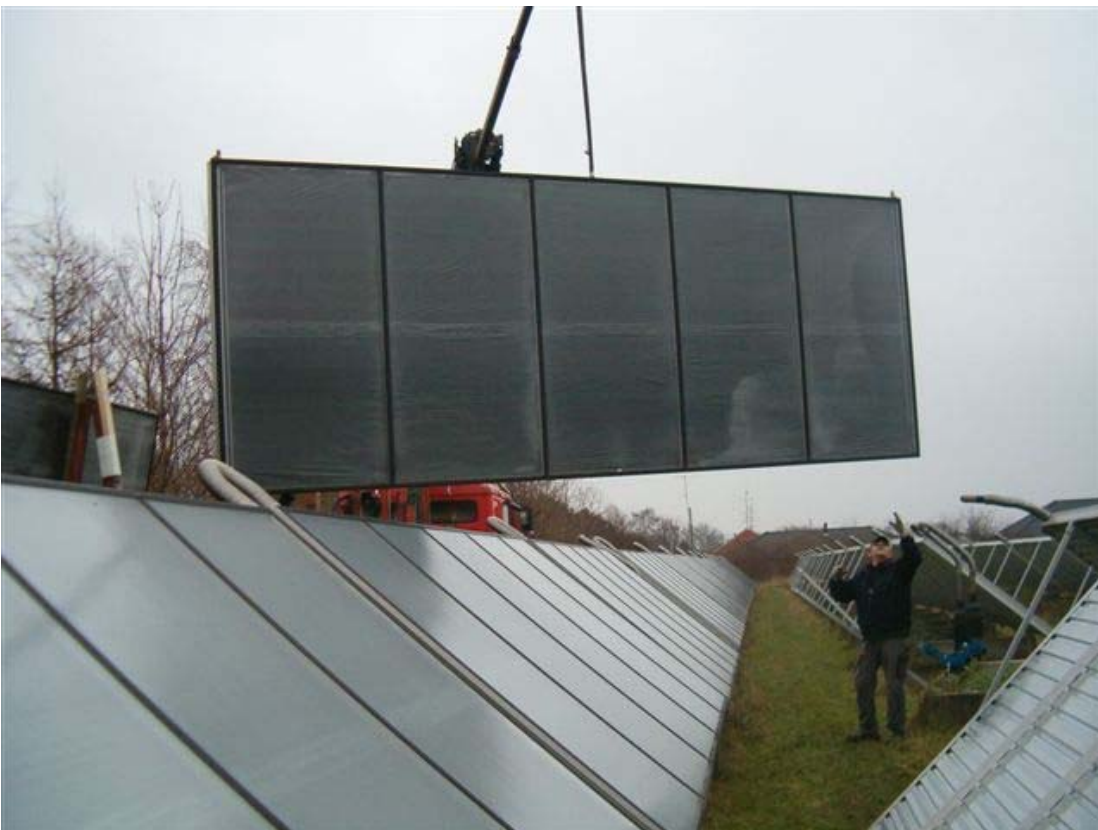
Figur 3. Solfanger fra Marstal nedtages.
