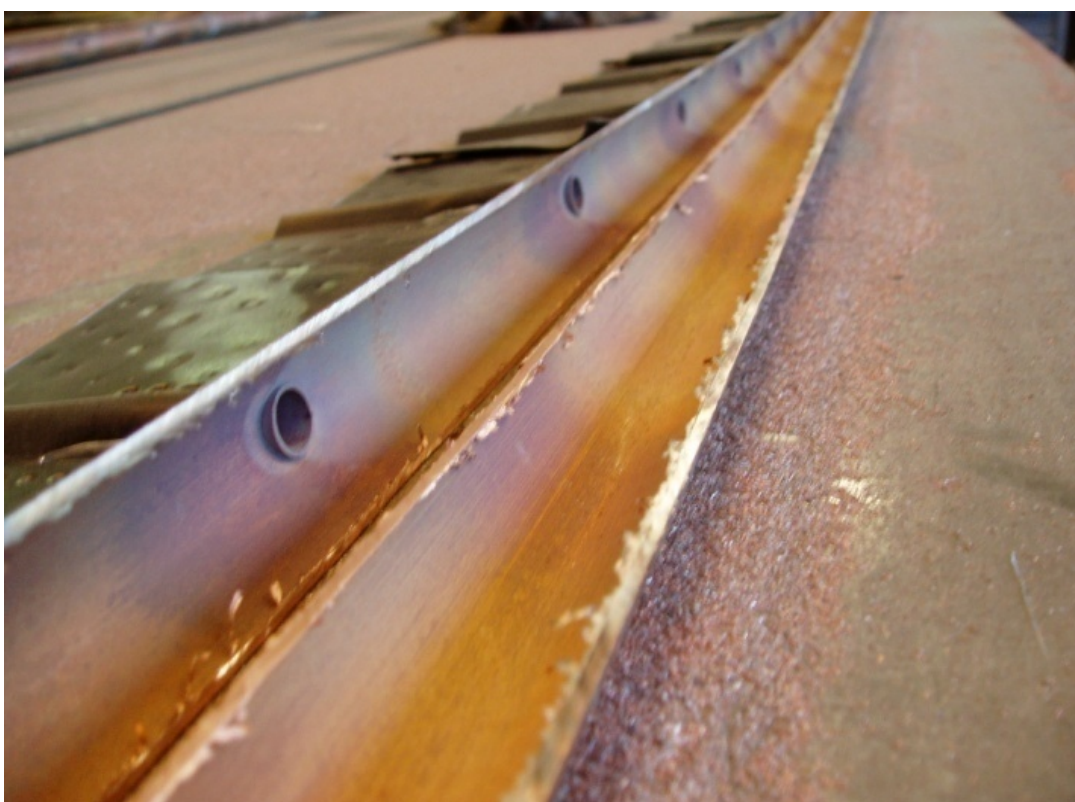
Figur 33. Udløbsmanifold for Marstal solfanger.
