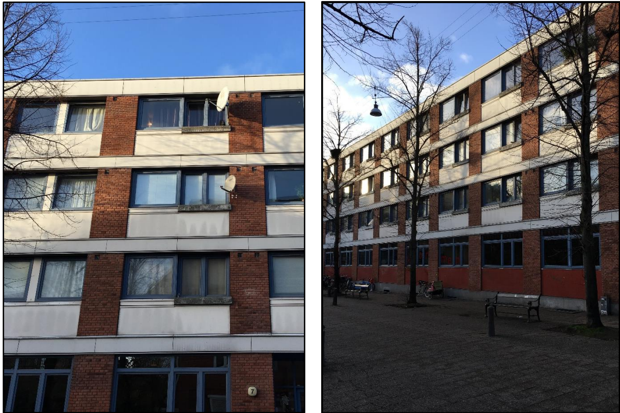
Figur 5. Facaden af Dagmargården, eksempel på etageboliger med betonbrystning
