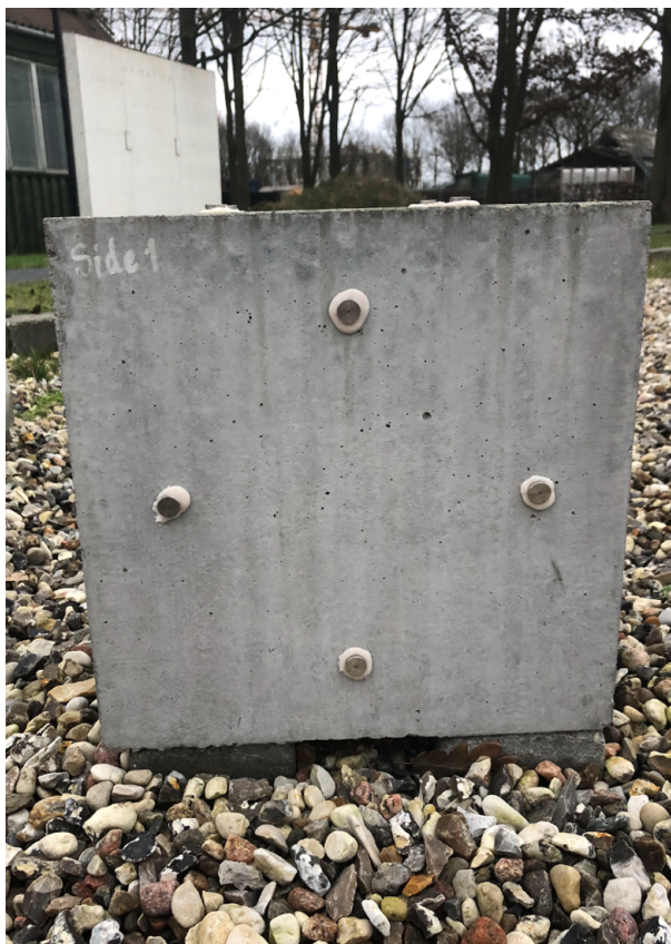
Figur 1: En betonblok med fire måletappe på DTU Byg's eksponeringsareal.
