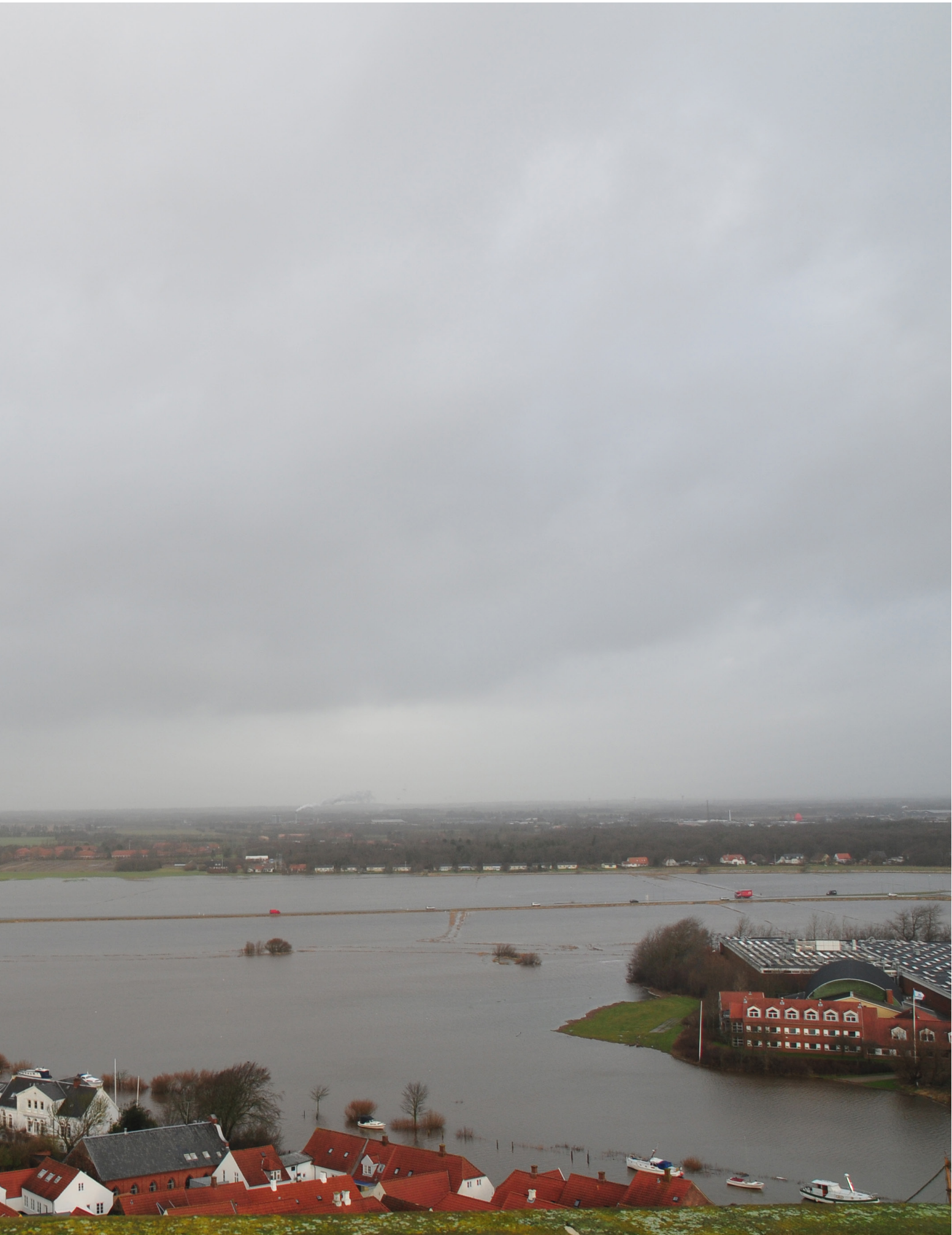
BÅDE BYGNINGER, INFRASTRUKTUR OG SOCIALE FORHOLD ER I RISIKO. FOTO: KYSTDIREKTORATET.
