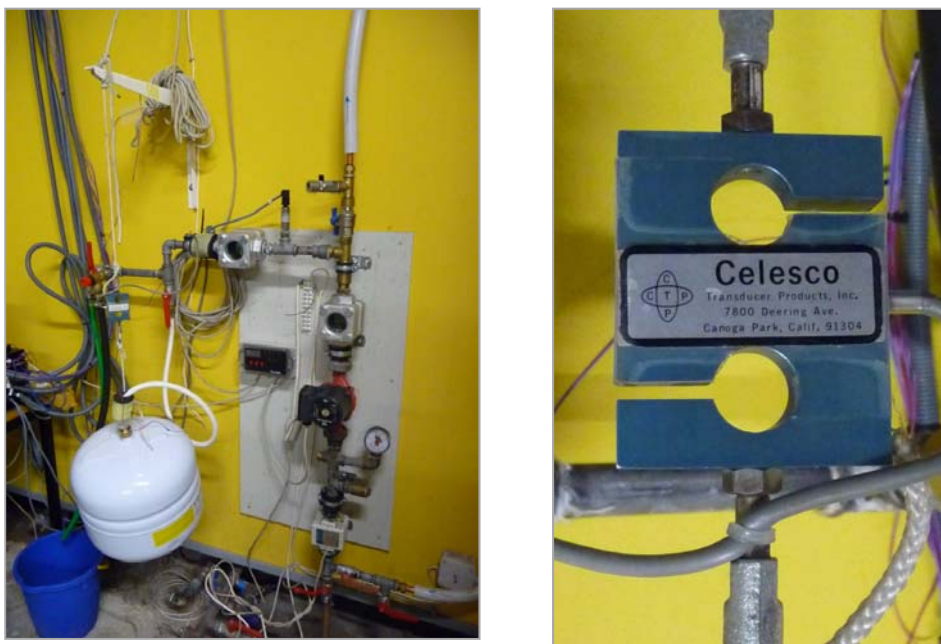
Figur 5. Ophæng af ekspansionsbeholder i en transducer.
