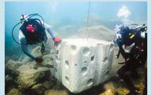
Andre steder placerer man kunstige rev lavet af beton i havneområder. Det kunstige rev har en speciel overfladestruktur, der betyder, at det hurtigt koloniseres af mange forskellige organismer.
