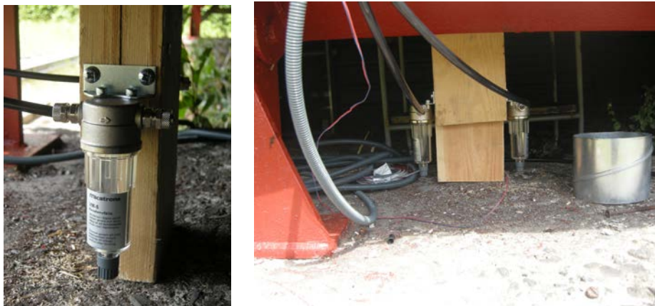
Figur 11. Kondensfælde/kondensopsamler
