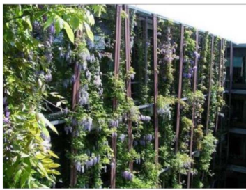
/Marco Schmidt: Energieeffiziente Gebäudekühlung, Paradigmenwechsel durch innovative Wasserkonzepte, USA-Tagung „Nachhaltige Kälteversorgung in Deutschland“, 2013, Dresden/
