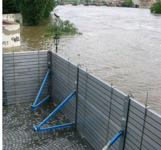
Figur 2-3. Midlertidig beskyttelse af byområder i Prag opnået ved at beredskabet har opstillet en midlertidig mur, der inddæmmer floden. Der er tilsvarende eksempler på beskyttelse af f.eks. Metroen i København, ligesom der er indkøbt pumper, sandsække og watertubes til udsatte områder.
