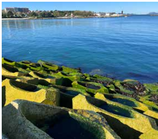
Coastallocks ved et kystbeskyttet område i Vigo. Man anvender natur-inclusive design for at fremme livet i havet. Foto: Maria Moltesen
