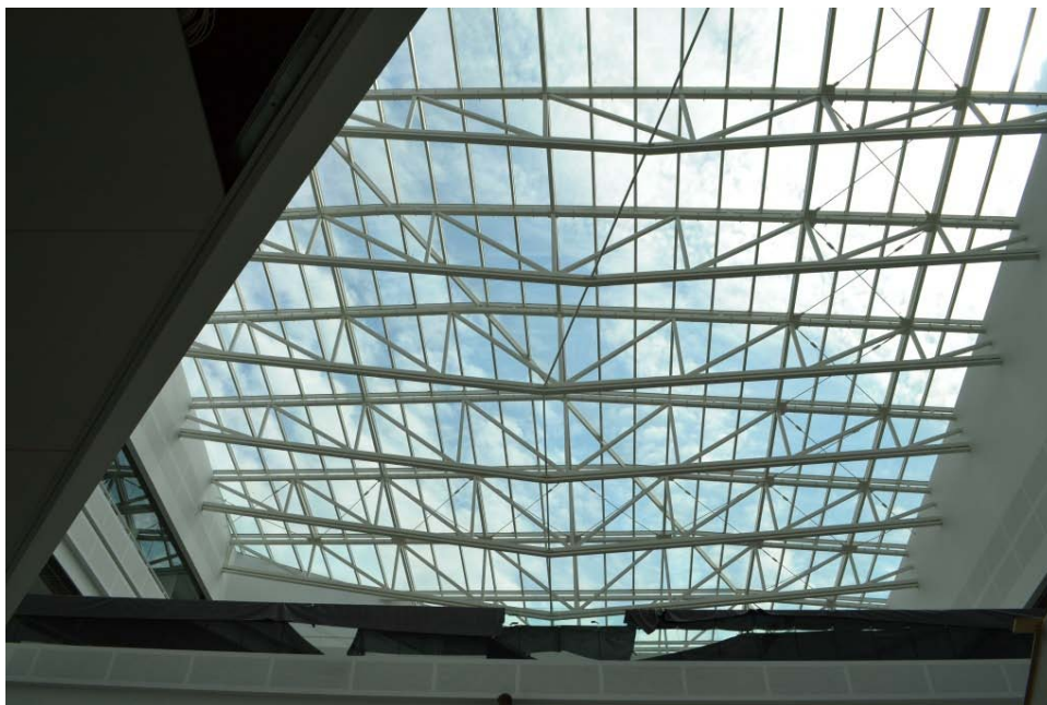
Fig. 6: Foto der viser stålkonstruktionen over ét af 3 atrier. Der blev anvendt 3D modelleringsværktøjer af CSK ved projekteringen af den komplekse geometri. Kilde: HSHansen website.
