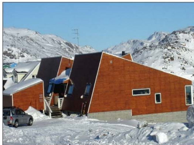
Figur 1. Lavenergihuset i Sisimiut (marts 2009).
