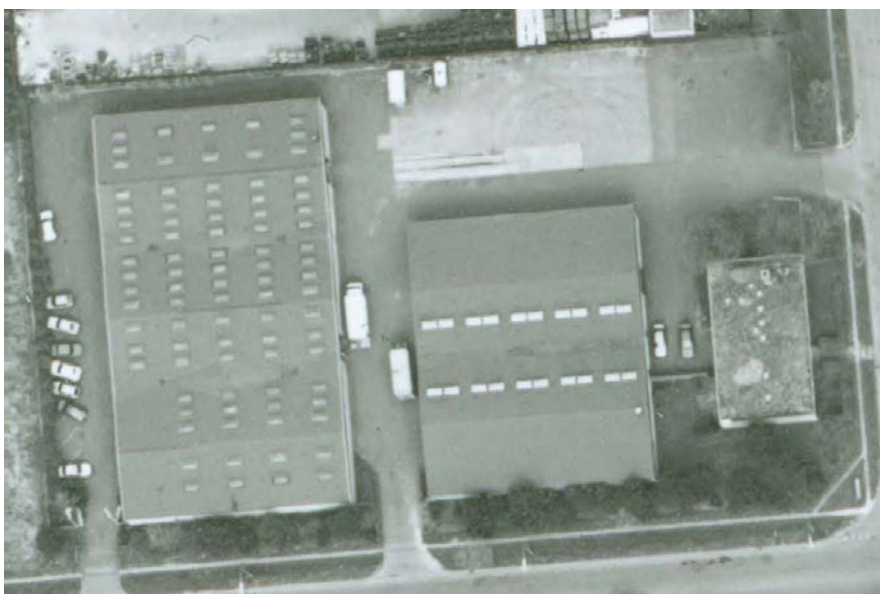
Figur 12: Naverland 26AB, Glostrup (flyfoto fra 1992). Fra venstre er det den nye industrihal, i midten den gamle industrihal og til højre er kontorbygningen. Det lyse område oven for den gamle industrihal, er dér hvor de chlorerede opløsningsmidler hovedsagligt blev håndteret, og hvor den underjordiske PCE-tank var placeret (Albertslund Kommune).
