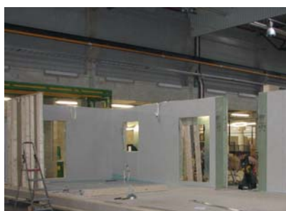
Figur 15 Samling af elementer
