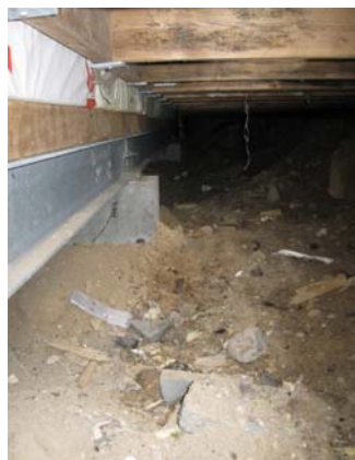
Figur 77, 78 opgravning, ingen fugtspærre
