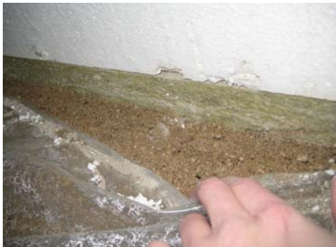
Figur 100 polystyrenisolering på og terrænbatte Figur 101 fugtmembran u. isolering
