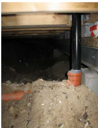
Figur 77, 78 opgravning, ingen fugtspærre
