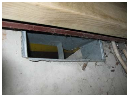
Figur 93 Ventilationsåbning i sokkel u. terrasse
