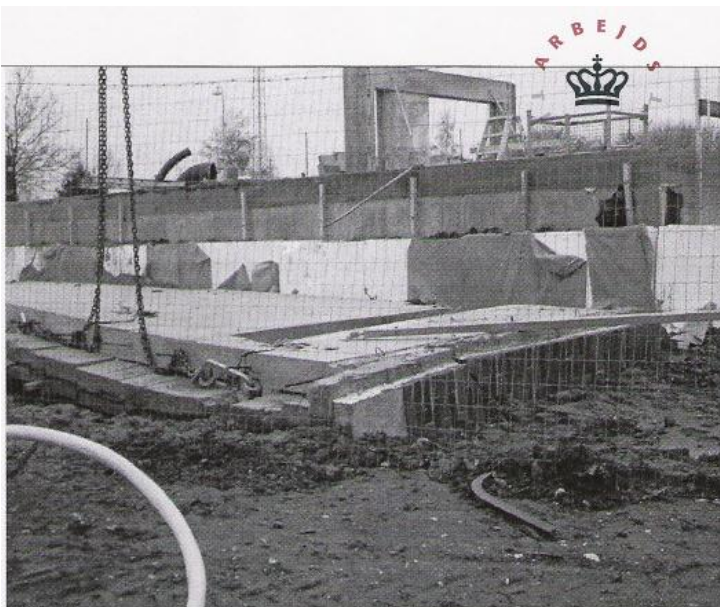
Billede 24: Arbejdstilsynets foto, der viser "gavlelement med udsparring, hvor forulykkede lå under. Forulykkede har stået ca. midtfor gavlen og arbejdet med understøbning". [Arbejdstilsynet]
