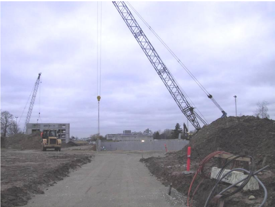
Billede 12: Montage af det tungeste kælder-element - væk fra kranen [december 2007].
