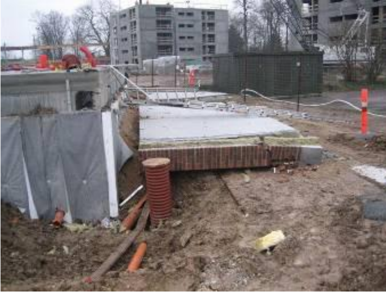
Billede 22: De to gavlelementerne vælter til jorden [14.1.2008].
