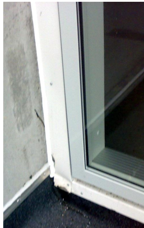
Billede 7: Fuge mellem Paroc-element og trappetårn [6. august 2008]
