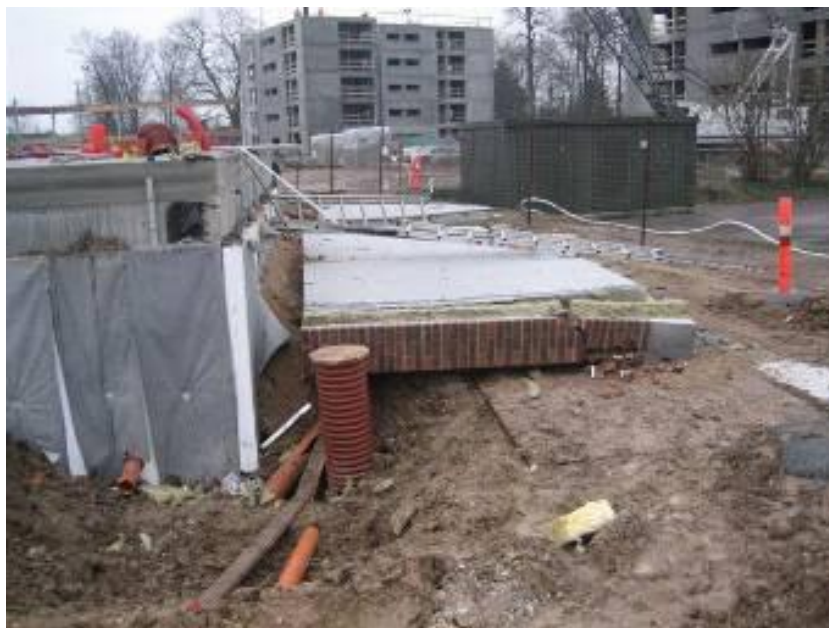
Billede 3: De to gavlelementerne vælter til jorden.
