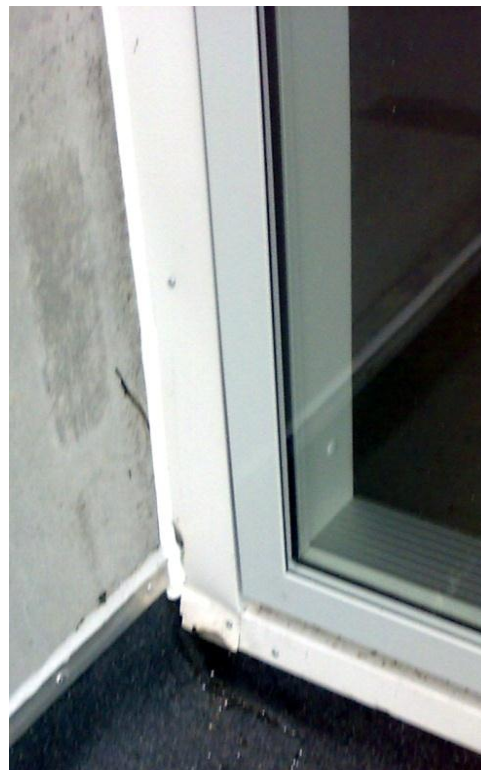
Billede 16: Fuge mellem Paroc-element og trappetårn [6. august 2008]
