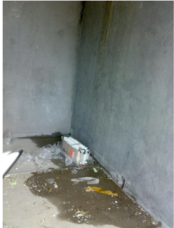
Billede 6: Vand på gulv i penthouse [6. august 2008].
