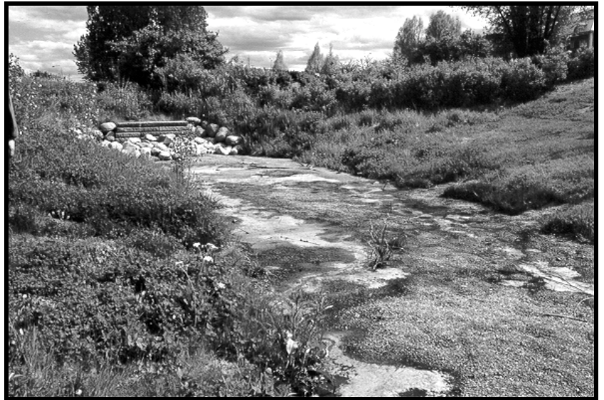
Fra rodzoneanlægget løber spildevandet ud i en tør bæk
