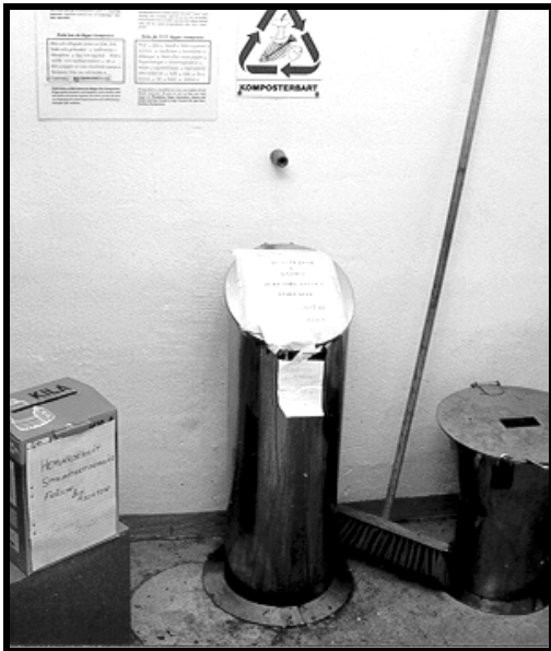
Grønt køkkenaffald hældes i skakt fra affaldsrum direkte ned i kompostbeholderen
