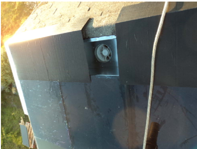
Figur 16 Montage på tag og under tag til varmeudtræk.
