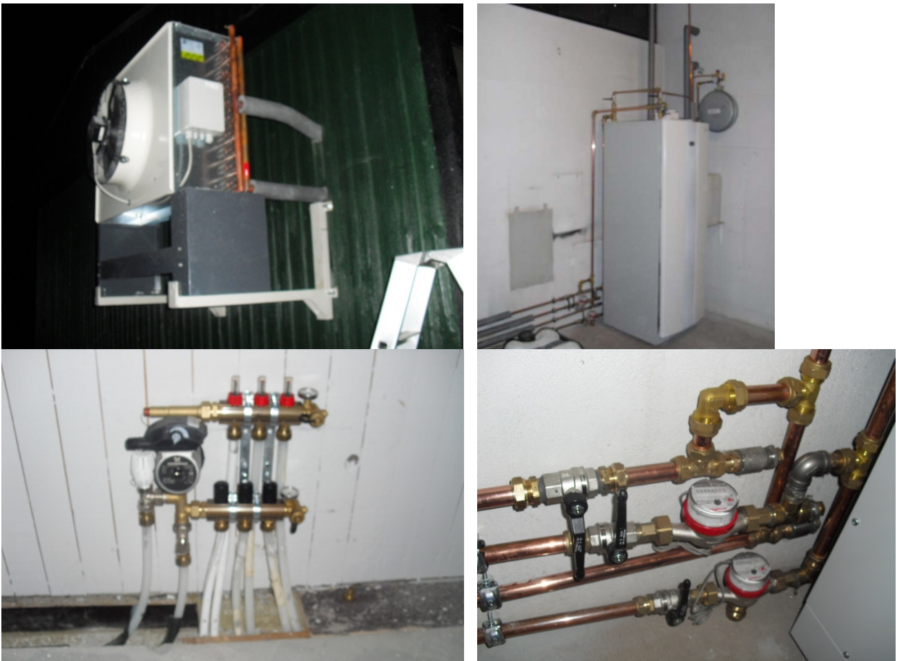
Figur 32 Installation af varmepumpe, samt tilslutning til radiatorkreds.
