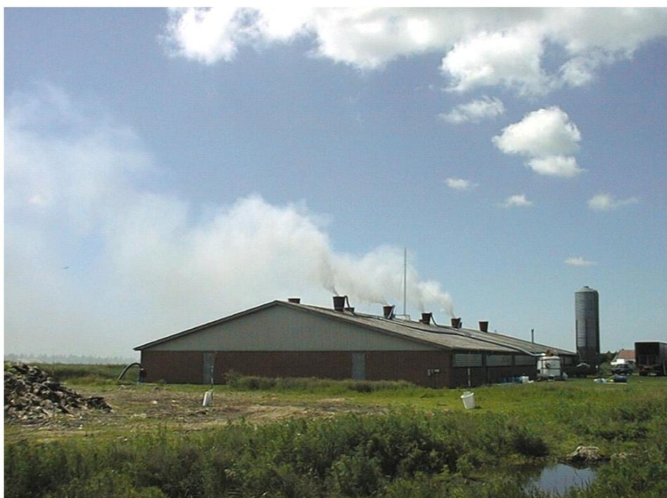
*Figur 1-1. Forsøgsstalden ved Roager er beliggende i et åbent fladt terræn uden større bygningsstrukturer inden for en radius af ca. 300 meter. Bygningen er 61 meter lang, 23 meter bred og 5,5 meter høj (1 kip) Taghældninger er 15°.*
