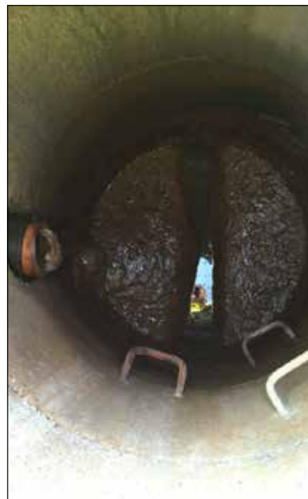
Slamophobning i kloakbrønd i Thyborøn.
