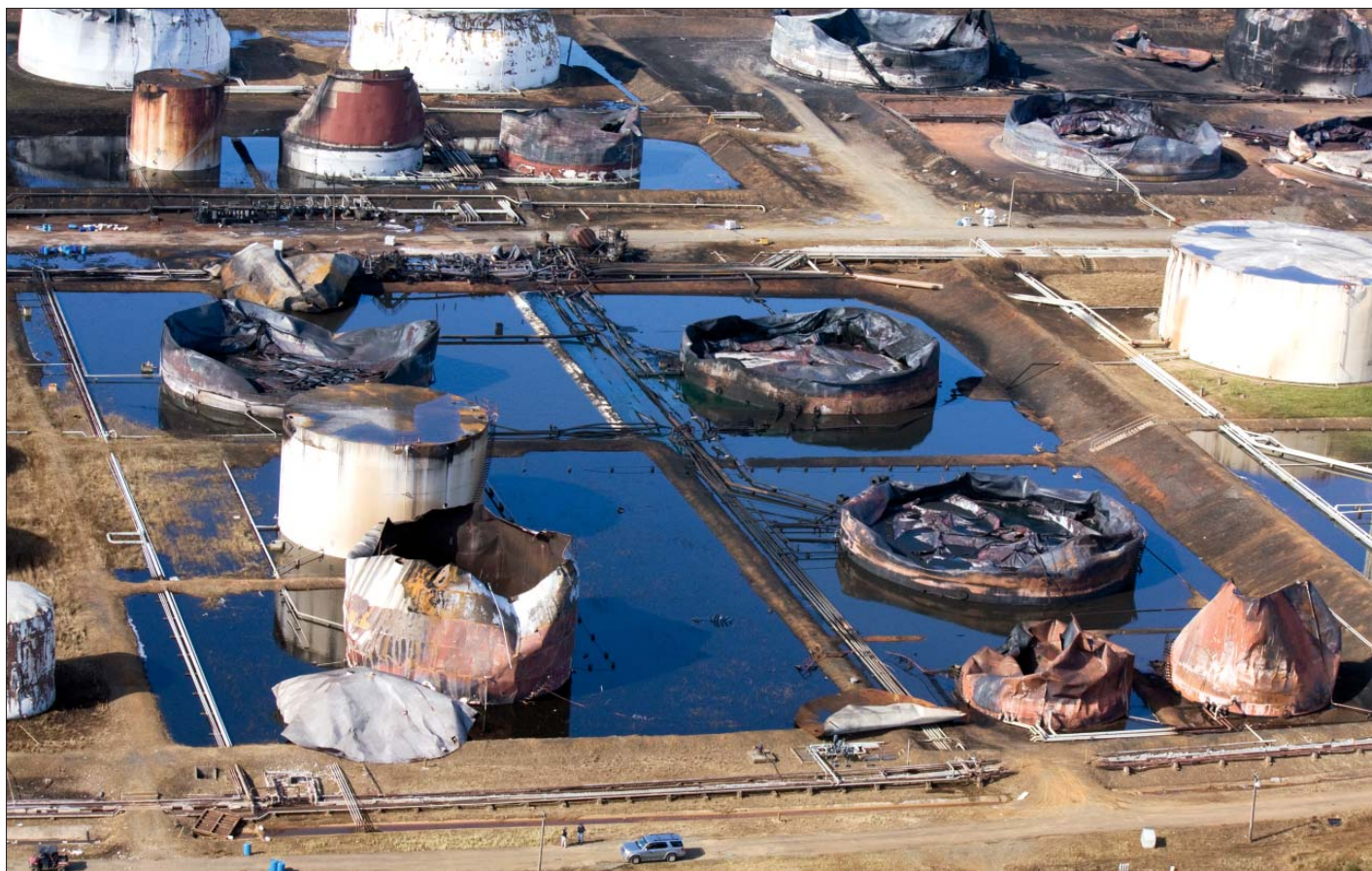
Billede af skaderne på tankene ved Caribbean Petroleum Corp. i Puerto Rico, USA. Foto: FEMA, Federal Emergency Management Agency.
