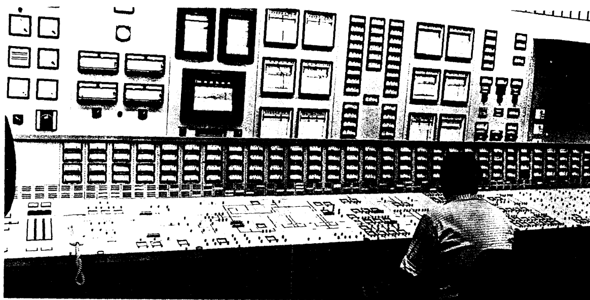
Figur 2. Traditionelle kontrolrum er baseret på ingeniørernes fremstilling i form af ligninger mellem variable. Hver måling er vist på sit eget instrument, derfor de mange instrumenter. Hvor er det overblik vi havde i figur 1?
