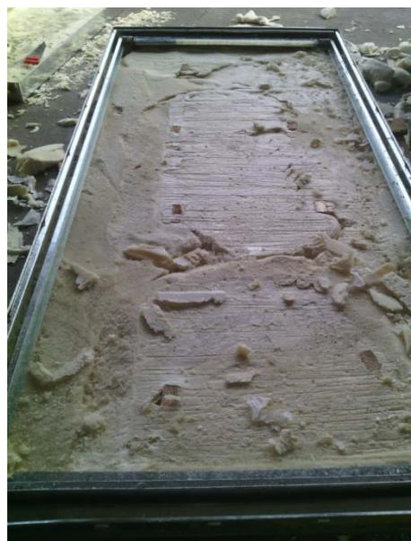
(d) Thermal insulation at the back
