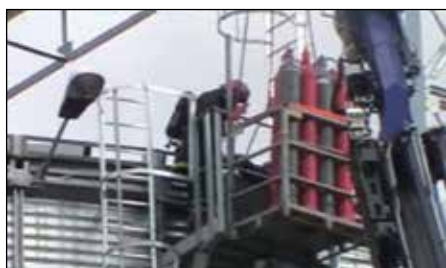
To brandfolk tømmer en kulsyreflaske ind i siloen gennem en inspektionslem i taget.
