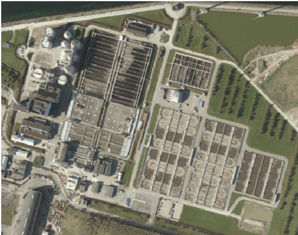
Figur 21. Ortofoto af Renseanlæg C (billede fra Danmarks Miljøportal).
