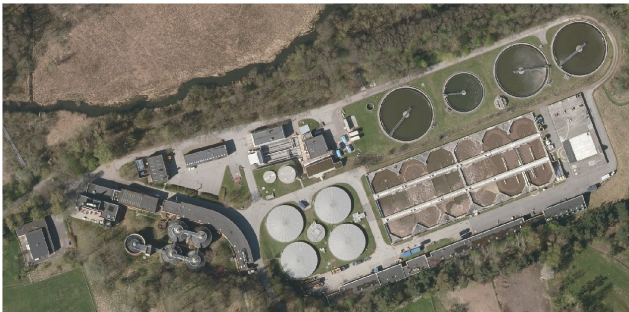
Figur 10. Ortofoto af Renseanlæg A (billede fra Danmarks Miljøportal).
