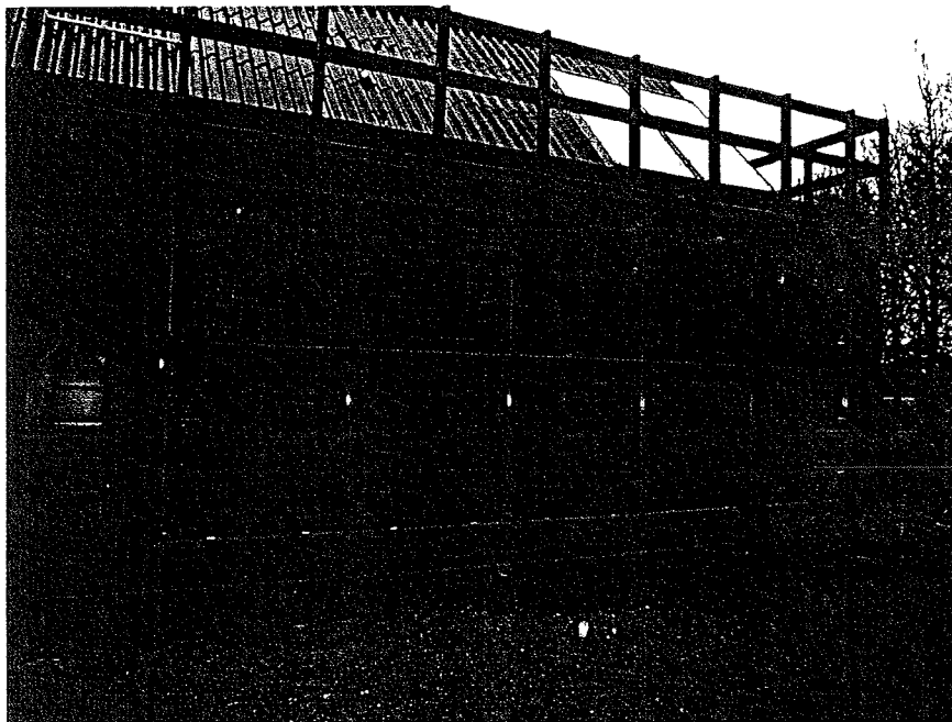
Figur 18: Solfangerfeltet ved inspektion med fremprovokering af kondens.
