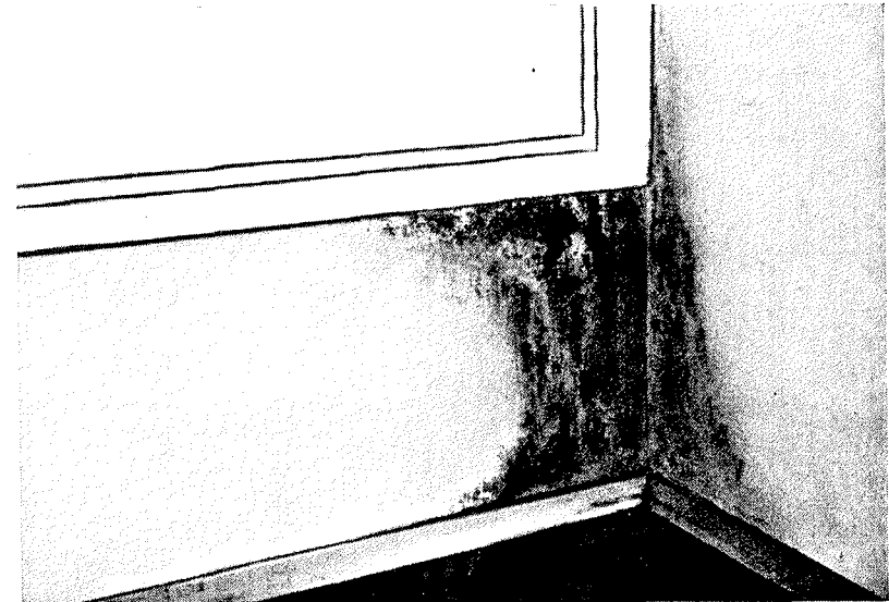
Fig. 23. Virkninger af kuldebroer.
