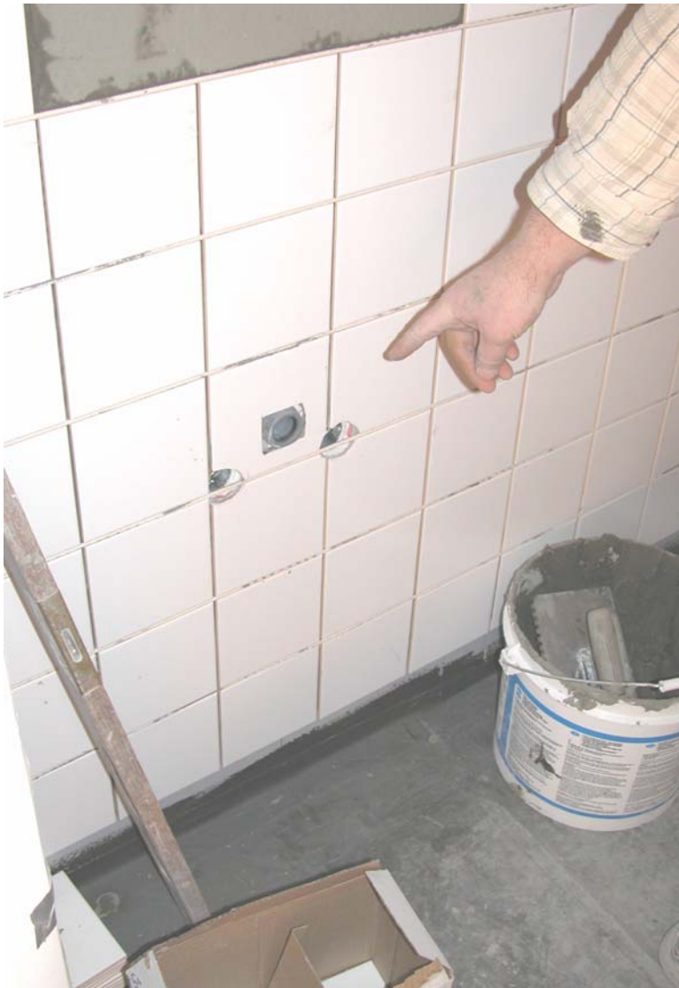
Figur 5. Placeringen af blandingsbatteriet følger ikke tegningerne med ekstraarbejde for murerne til følge
