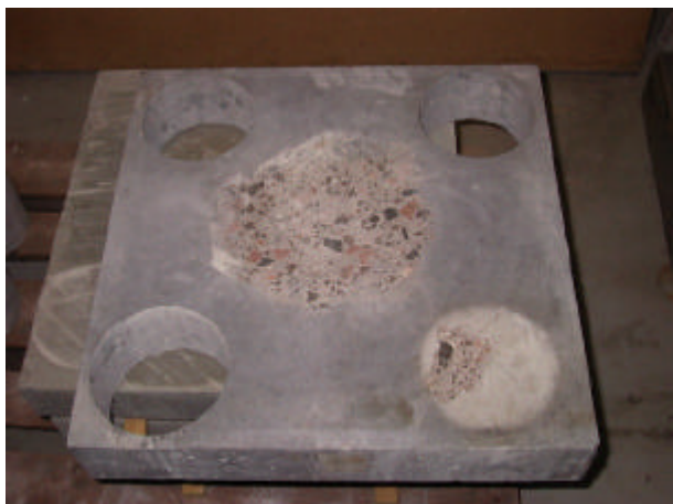
Figur 2.14. Foto af betonflise nr. 9 med 3 huller fra udborede betonkærner. Afskallet område på midt samt cirkulært område ø 140 mm i nederste højre hjørne med afskalning (30 %).
