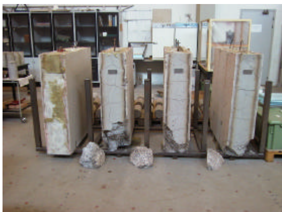
Figur 4.12. Foto fra DTU af de fire betonvægelementer efter endt brandprøvning på DBI. Bemærk revner på tværs af væggene.
