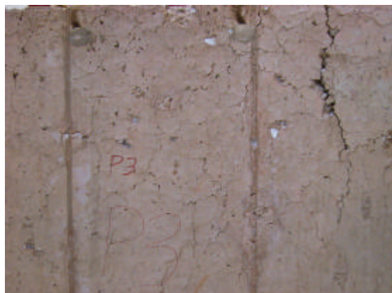
Figur 4.14. Foto af brandpåvirkede vægelement med betontype P3.
