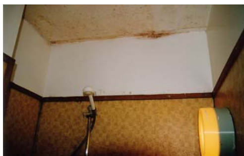
Figur 7 Eksempel på fugtproblem i badeværelse
