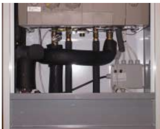
Figur 2-1: Billede af unit og rørføring i unit.
