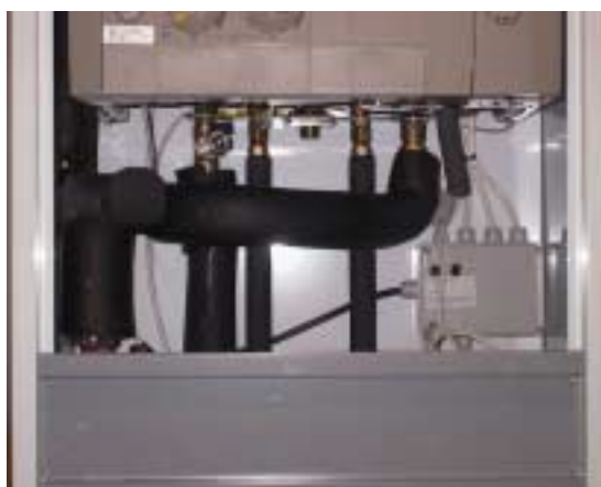
Figur 2-1: Billede af unit og rørføring i unit.
