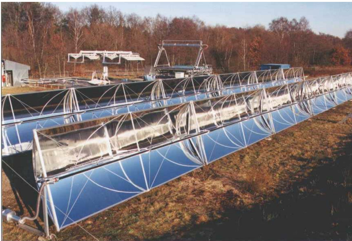
Figur 7 TROUGH solfangeren med reflektor og rør absorber. (Krüger, D., Heller, A., Hennecke, K., and Duer, K., 2000)
