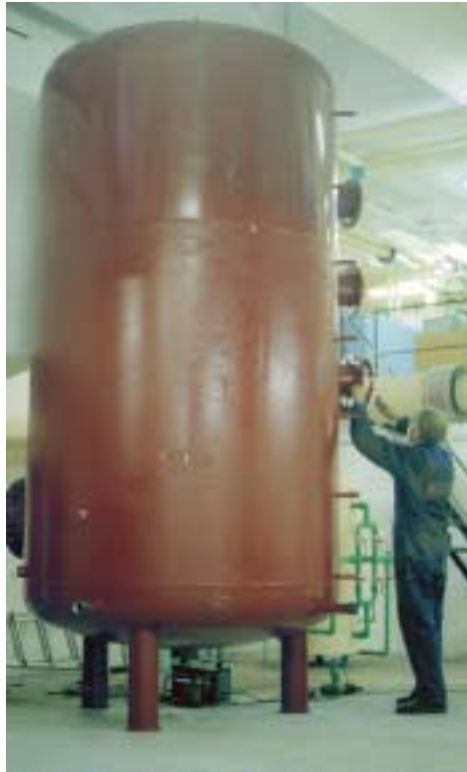
Figur 7. 10.000 l uisoleret varmtvandsbeholder med skueglas.
