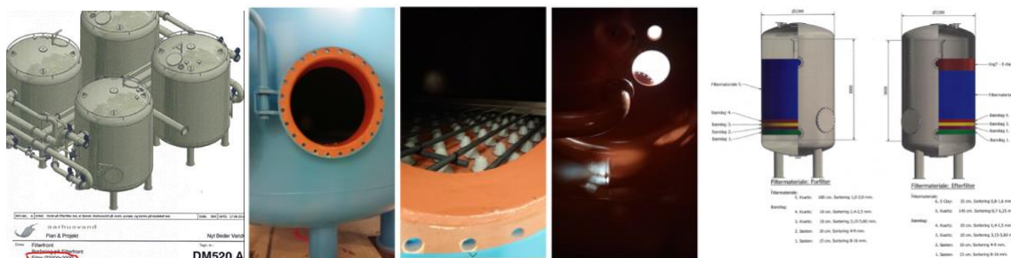
Figur 8: Filtertanke på Bederværket, Aarhus Vand med epoxy-belægning anvendt til feltundersøgelser.
