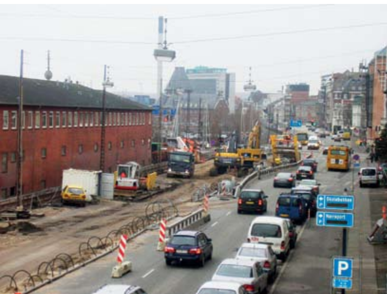
Etablering af nye større ledningsanlæg i Århus midtby
