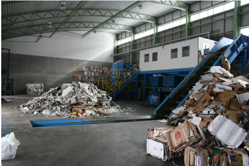
Figur 6.1 Interkommunali Renovatiónsfelagsskapurin (IRF)s omlastningsstation for papir, pap og plastik i Leirvik. Sorteringsanlægget ses til højre i billedet (foto: Eisted privat foto).
