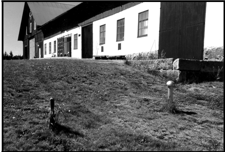
Urintank med udluftning er placeret i skrænt
