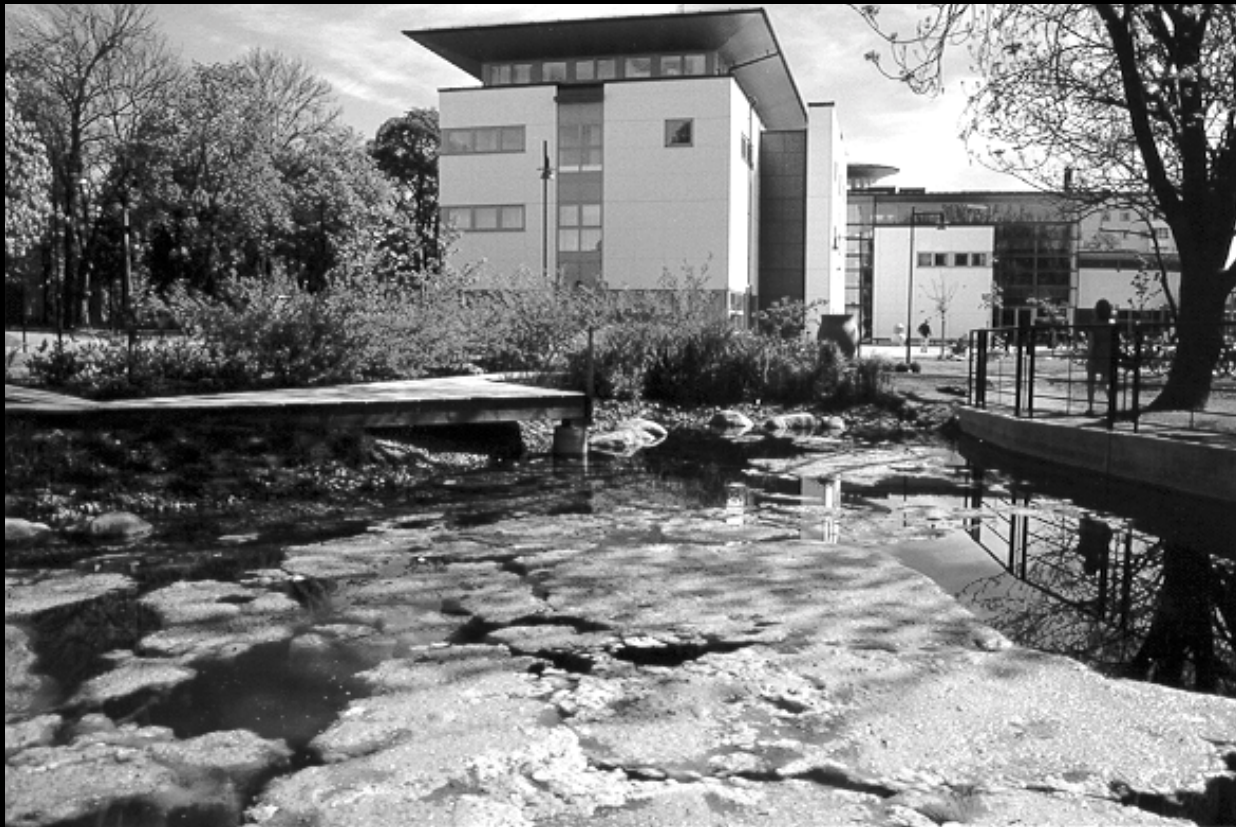
Teknikhuset på Kalmars Terkniske Højskole
