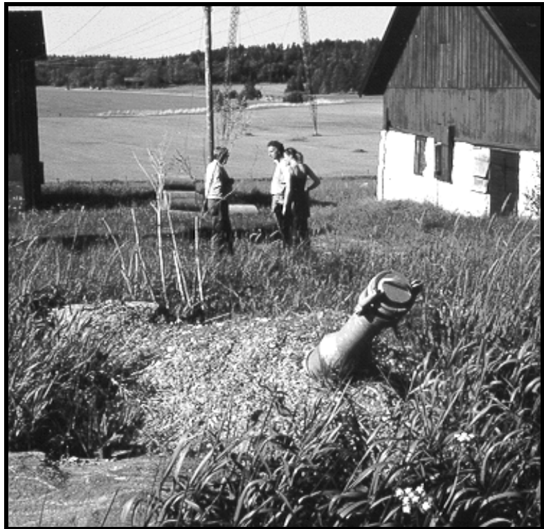
Urinlageret fyldes (og tømmes) ved gravitation
